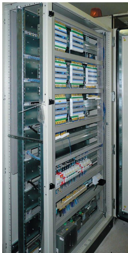
Do rozvaděče je instalováno 10 jednotek DataLab IO4
